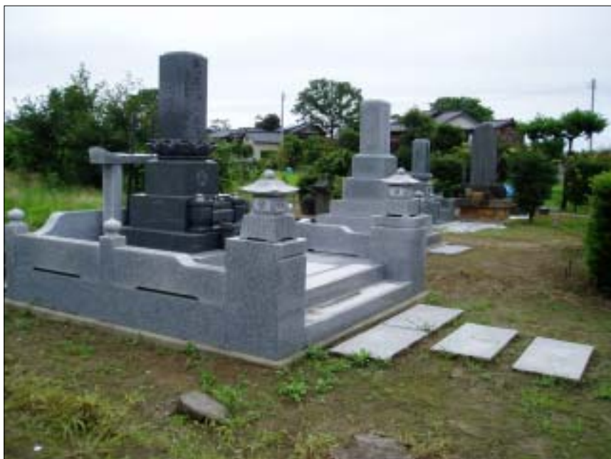
写真名：中田-9、墓石の状況 撮影箇所：中田地内 撮影日：2007年 7月 22日 コメント：北鯖石小学校の裏にある墓地では、新しい墓は転倒を免れているものが多い。
