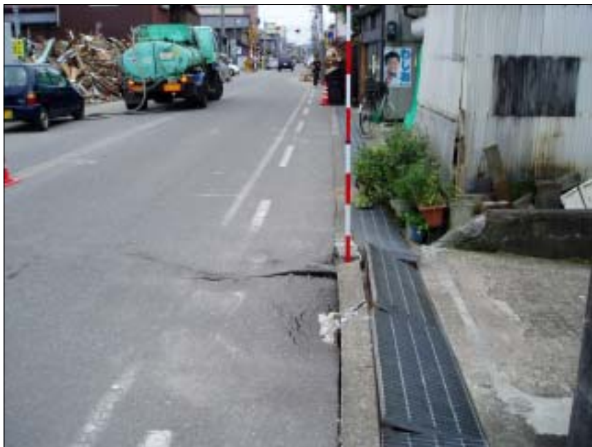
写真名：東本町-4、道路側溝の破損 撮影箇所：東本町地内 撮影日：2007年 7月 22日 コメント：家屋のダメージと比較して、道路や道路構造物の被害は比較的小さいように見えた。
