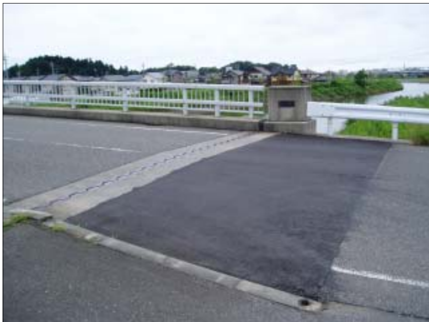
写真名：元城-4、新金曲輪橋の補修 撮影箇所：元城町地内 撮影日：2007年 7月 22日 コメント：柏崎総合高校近くの橋梁、取り付け部が沈下したため舗装の補修が実施している状況
