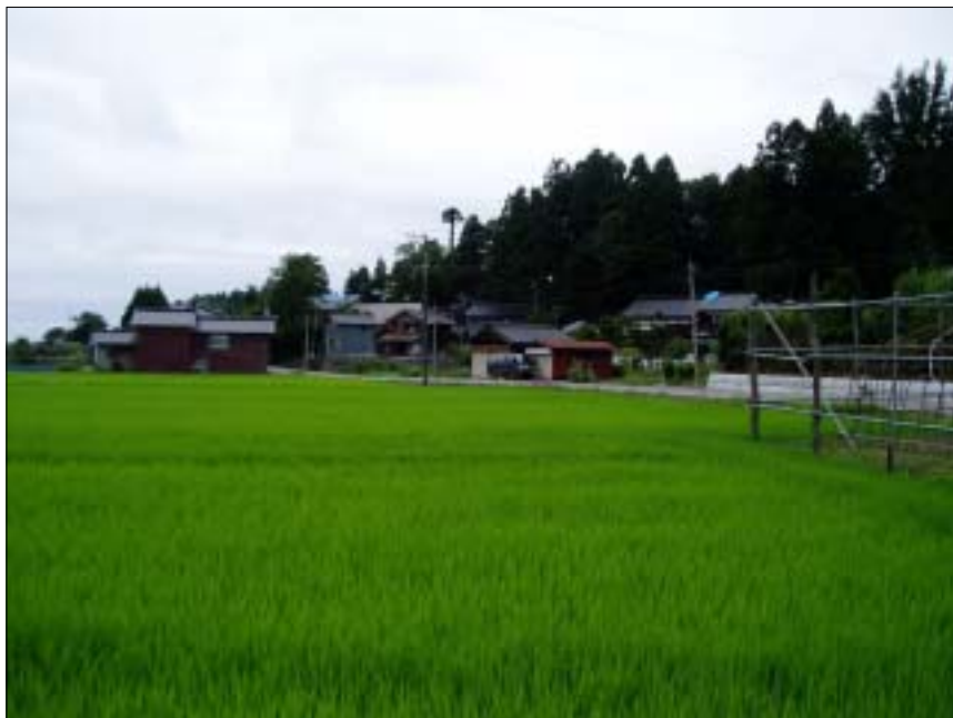
写真名：畔屋-4、家屋の被災状況 撮影箇所：畔屋地内、丘陵南側 撮影日：2007年 7月 22日 コメント：畔屋地内では、屋根にブルーシートを張った被災家屋が散見される
