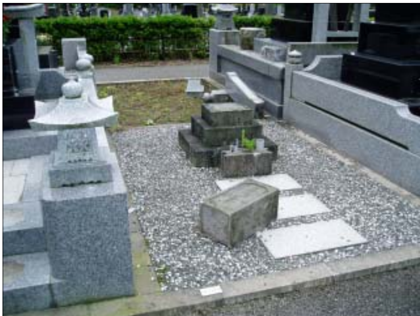
写真名：堀-13、墓石の転倒 撮影箇所：堀地内、県道73号 撮影日：2007年 7月 22日 コメント：古い墓石や新しくても不安定な飾り石が転倒している状況
