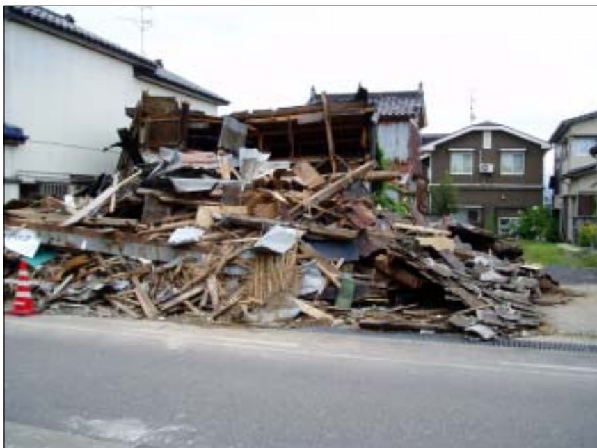
写真名：東本町-6、倒壊した建物 撮影箇所：東本町地内 撮影日：2007年 7月 22日 コメント：越後線を越えて東本町に入ると倒壊した建物が多数見受けられ、ほとんど原型を留めていない。
