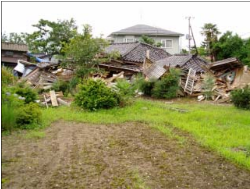
写真名：中道-1、家屋の倒壊 撮影箇所：中道地内、県道73号沿い 撮影日：2007年 7月 22日 コメント：県道脇の古い家屋が完全に倒壊している状況
