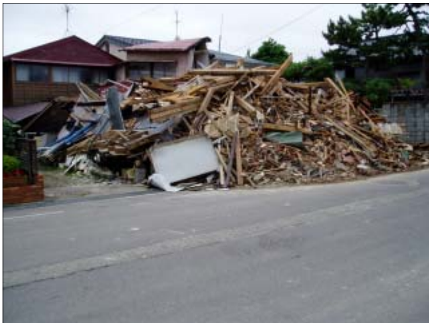
写真名：東本町-1、倒壊した建物 撮影箇所：東本町地内 撮影日：2007年 7月 22日 コメント：越後線を越えて東本町に入ると倒壊した建物が多数見受けられ、ほとんど原型を留めていない。
