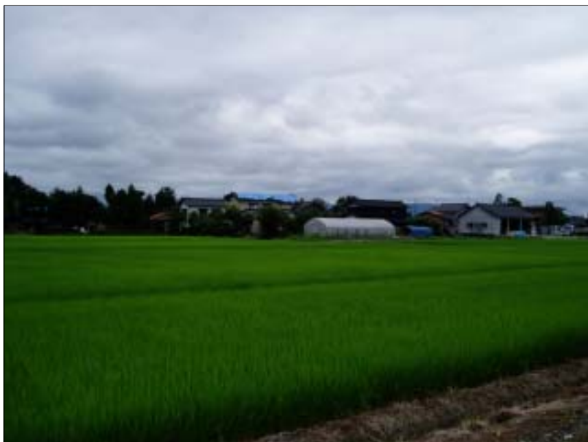
写真名：中田-3、家屋の被災状況 撮影箇所：中田地内 撮影日：2007年 7月 22日 コメント：畔屋地内から中田地内を臨むと、屋根にブルーシートを掛けた被災家屋が散見される。
