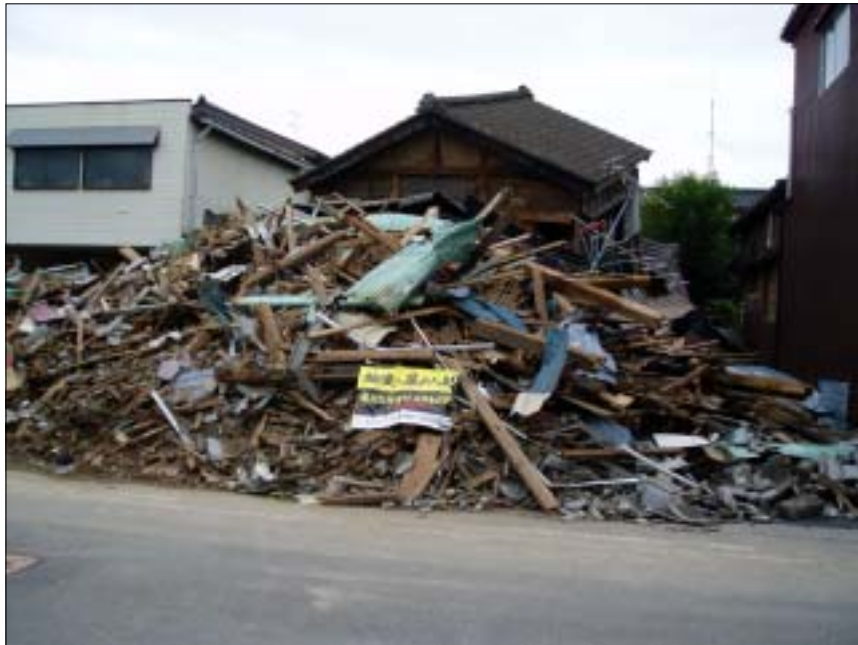
写真名：東本町-2、倒壊した建物 撮影箇所：東本町地内 撮影日：2007年 7月 22日 コメント：越後線を越えて東本町に入ると倒壊した建物が多数見受けられ、ほとんど原型を留めていない。
