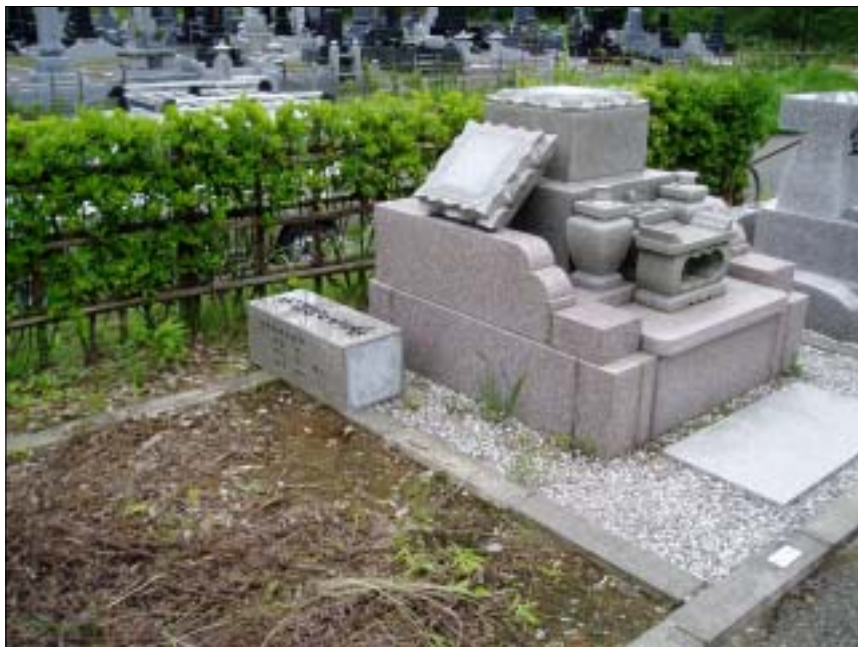
写真名：堀-10、墓石の転落 撮影箇所：堀地内、柏崎墓園 撮影日：2007年 7月 22日 コメント：比較的新しい墓であるが、墓石を積み上げただけの構造であり、落下している。
