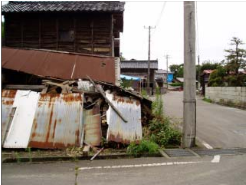
写真名：中田-11、家屋の被災状況 撮影箇所：中田地内 撮影日：2007年 7月 22日 コメント：北鯖石小学校の周辺では、古い建物を中心に倒壊したり、大きく傾いている建物が多い。
