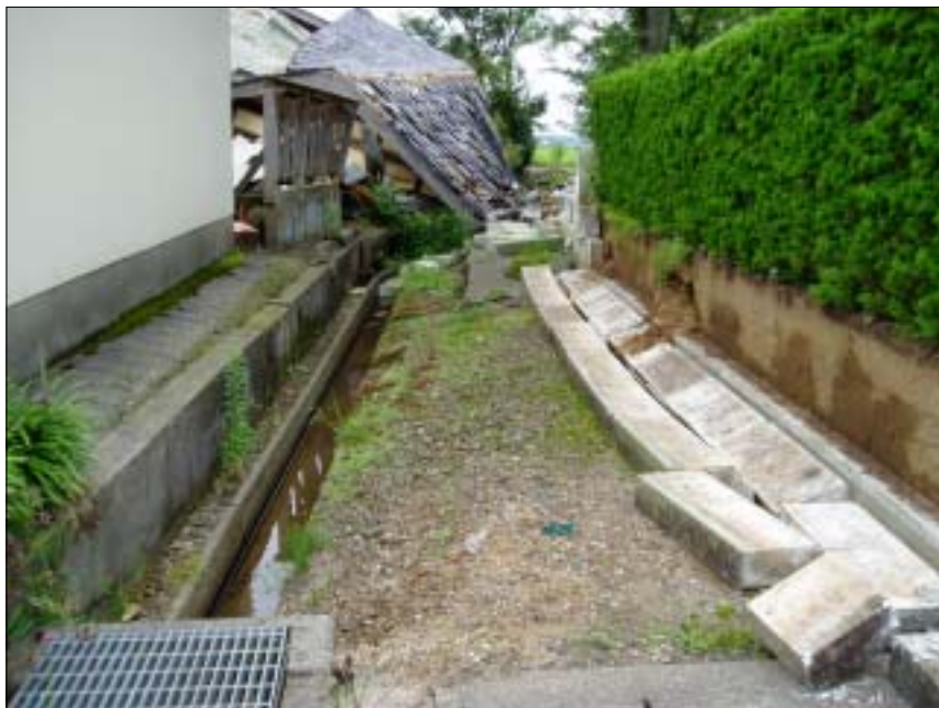
写真名：中田-10、家屋の被災状況 撮影箇所：中田地内 撮影日：2007年 7月 22日 コメント：北鯖石小学校の周辺では、古い建物の外、古い石積なども倒壊している事例が多い。
