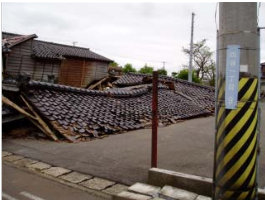
写真名：四谷1-3、家屋の倒壊 撮影箇所：四谷1丁目 撮影日：2007年 7月 22日 コメント：比角小学校から白竜公園側に昇ると、多くの損傷家屋が見られる。古い砂丘の上に相当し、地質との関連性が考えられる。
