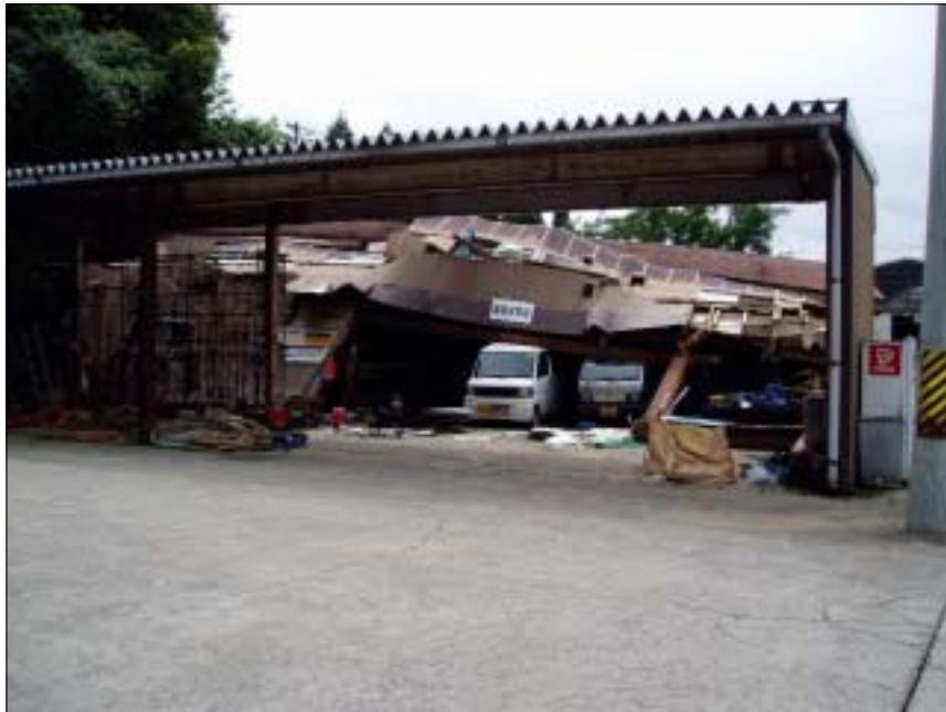
写真名：畔屋-8、家屋の倒壊 撮影箇所：畔屋地内、丘陵北側 撮影日：2007年 7月 22日 コメント：建設会社の仮設材置場が完全に倒壊して、車が押し潰されている。
