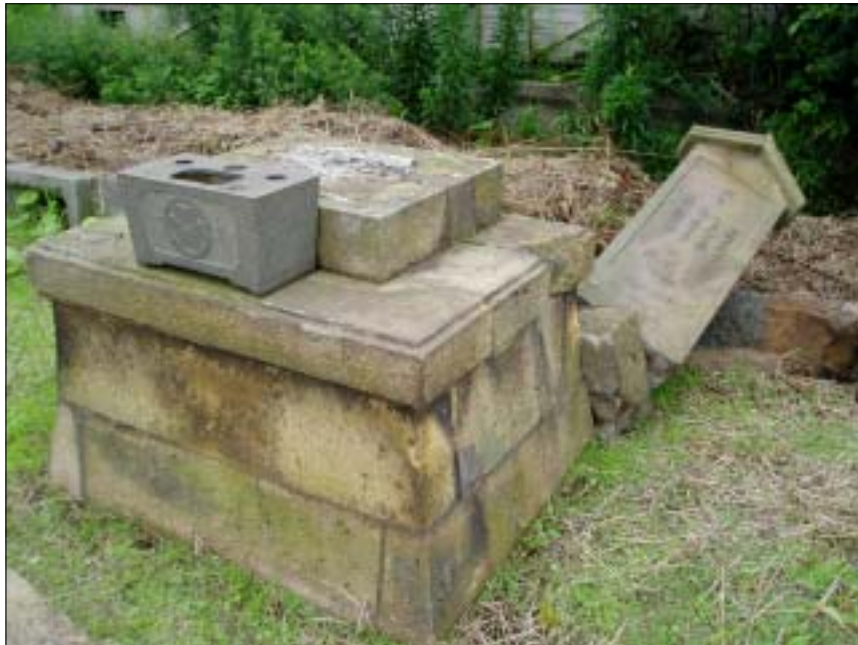
写真名：中田-8、墓石の転落 撮影日：2007年 7月 22日 コメント：北鯖石小学校の裏にある墓地では、古いお墓を中心に倒れているものが多い。
