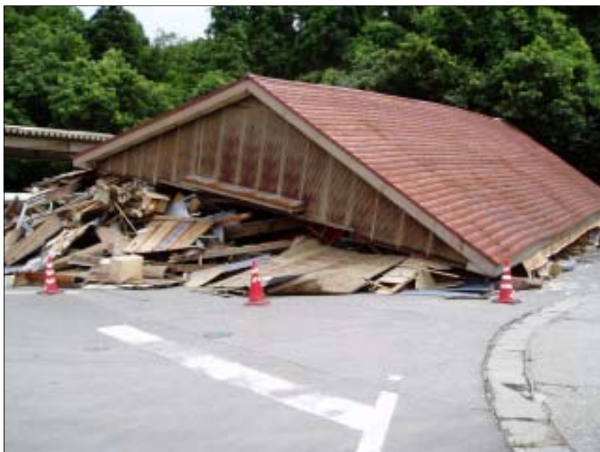
写真名：畔屋-9、家屋の倒壊 撮影箇所：畔屋地内、丘陵北側 撮影日：2007年 7月 22日 コメント：建設会社の仮設材置場が完全に倒壊して、車が押し潰されている。
