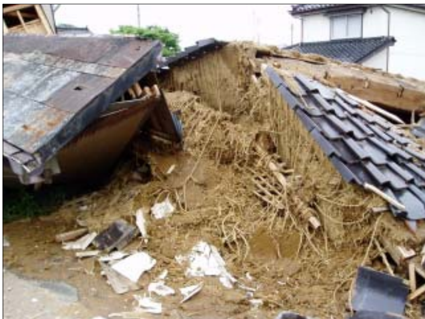
写真名：関町-6、建物の壁構造 撮影箇所：関町地内 撮影日：2007年 7月 22日 コメント：倒壊したてて物の 内部から、土壁が露出してい る状況
