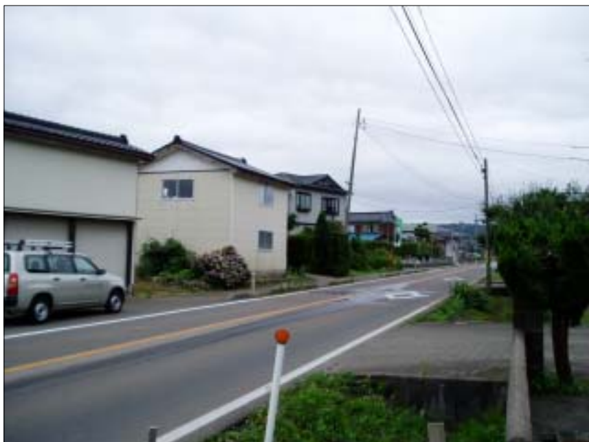
写真名：上方-3、屋根の損傷 撮影箇所：上方地内 撮影日：2007年 7月 22日 コメント：上方地内では、 所々で屋根に損傷が見られ、 ブルーシートが掛かっている 状況
