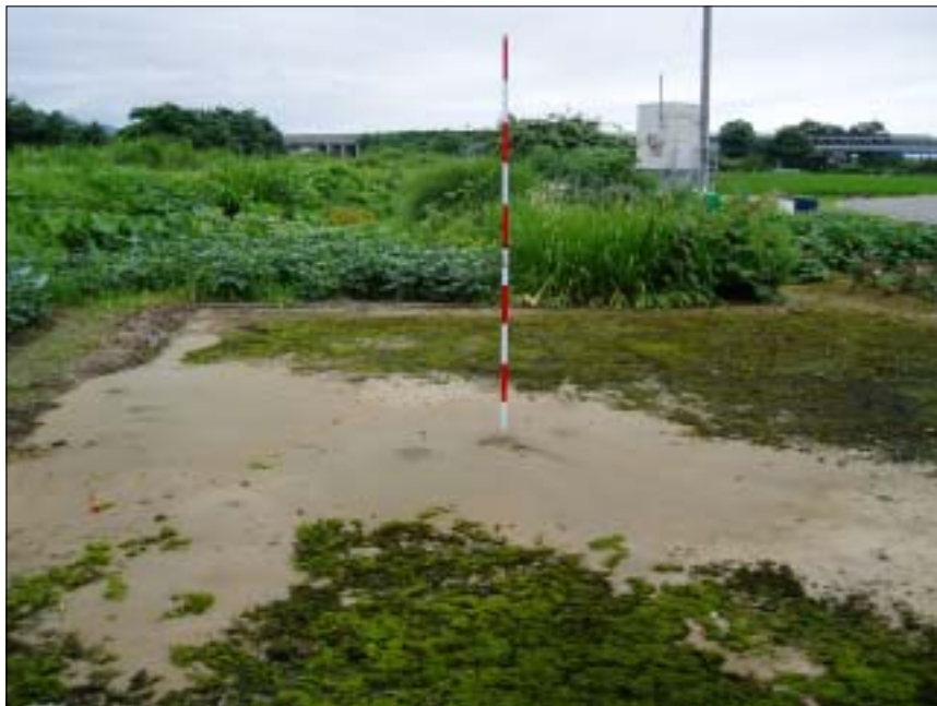
写真名：中田-14、液状化による噴砂 撮影箇所：中田地内 撮影日：2007年 7月 22日 コメント：鯖石川の右岸では、液状化による噴砂の跡が残っている。
