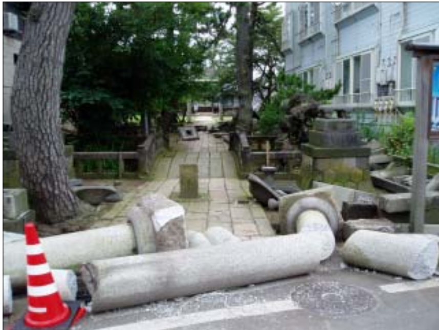
写真名：比角1-2、鳥居の倒壊 撮影箇所：比角1丁目地内 撮影日：2007年 7月 22日 コメント：羽森神社前の鳥居や玉垣が倒壊している状況。古い石造物はかなりの確立で倒壊している。
