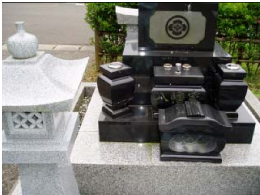
写真名：堀-15、花立の移動 撮影箇所：堀地内、県道73号 撮影日：2007年 7月 22日 コメント：新しくても固定していない花立などは、地震動によって移動している。
