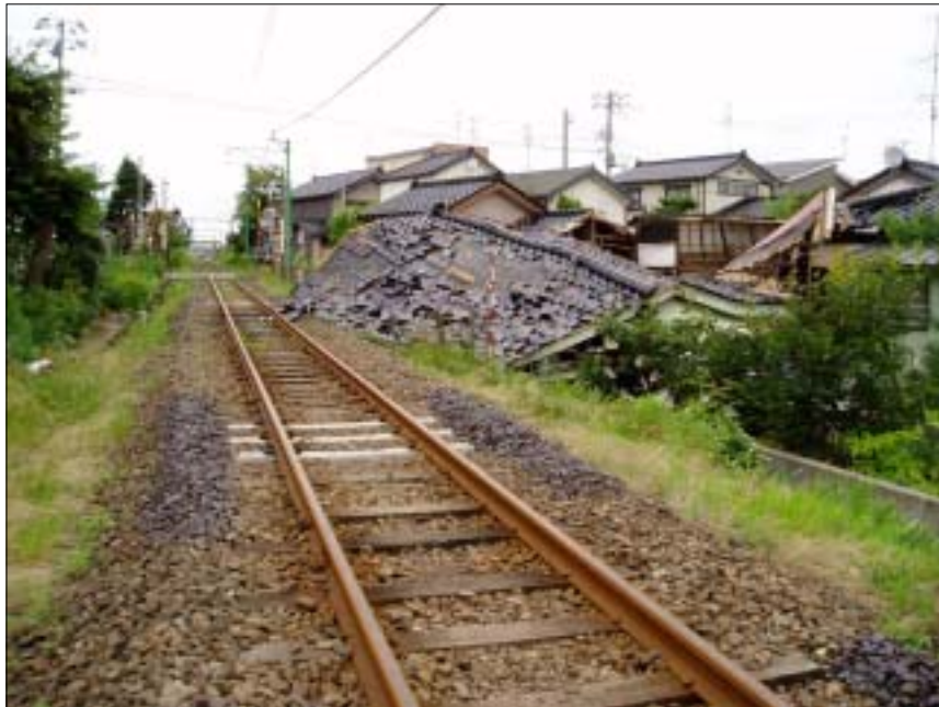
写真名：四谷1-4、鉄道の損傷 撮影箇所：四谷1丁目 撮影日：2007年 7月 22日 コメント：越後線の東柏崎駅の手間で、家屋が倒壊して線路にはみ出ている状況、北側を望む
