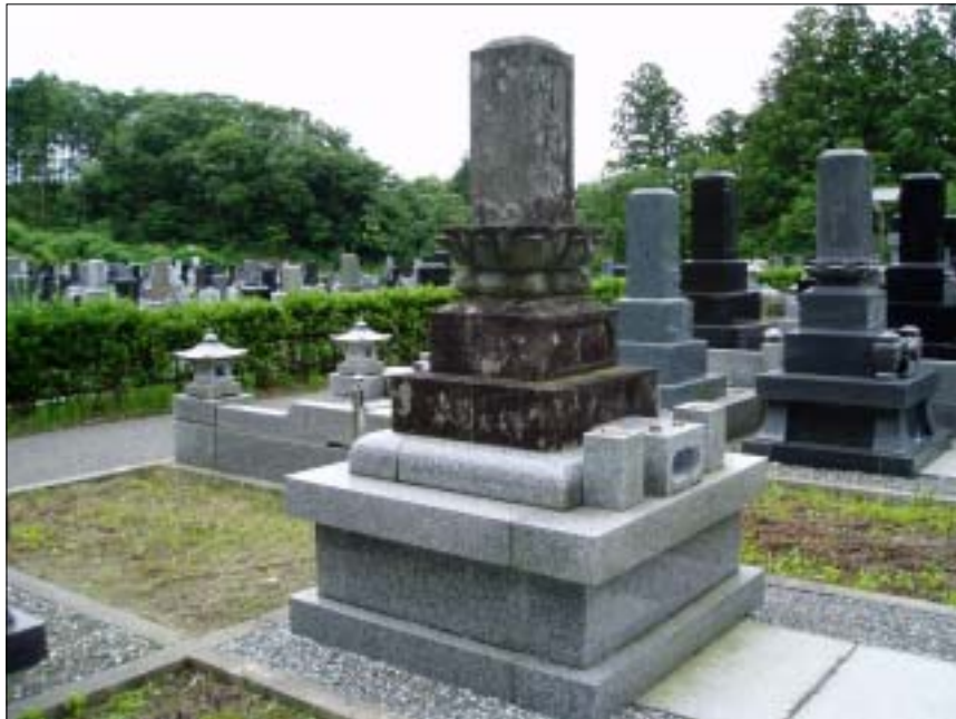
写真名：堀-14、補修した墓石？ 撮影箇所：堀地内、柏崎墓園 撮影日：2007年 7月 22日 コメント：先の中越地震で補修したと思われ墓石は、転倒していない。
